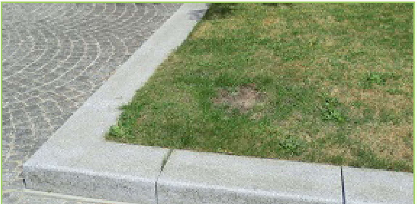
Betonbalken of boordstenen zijn nuttig bij het overbruggen van een niveauverschil zoals in de Ab- dij van Averbode / Les bordures de béton ou de pierres sont utiles pour combler une différence de niveau, comme à l'abbaye d'Averbode
