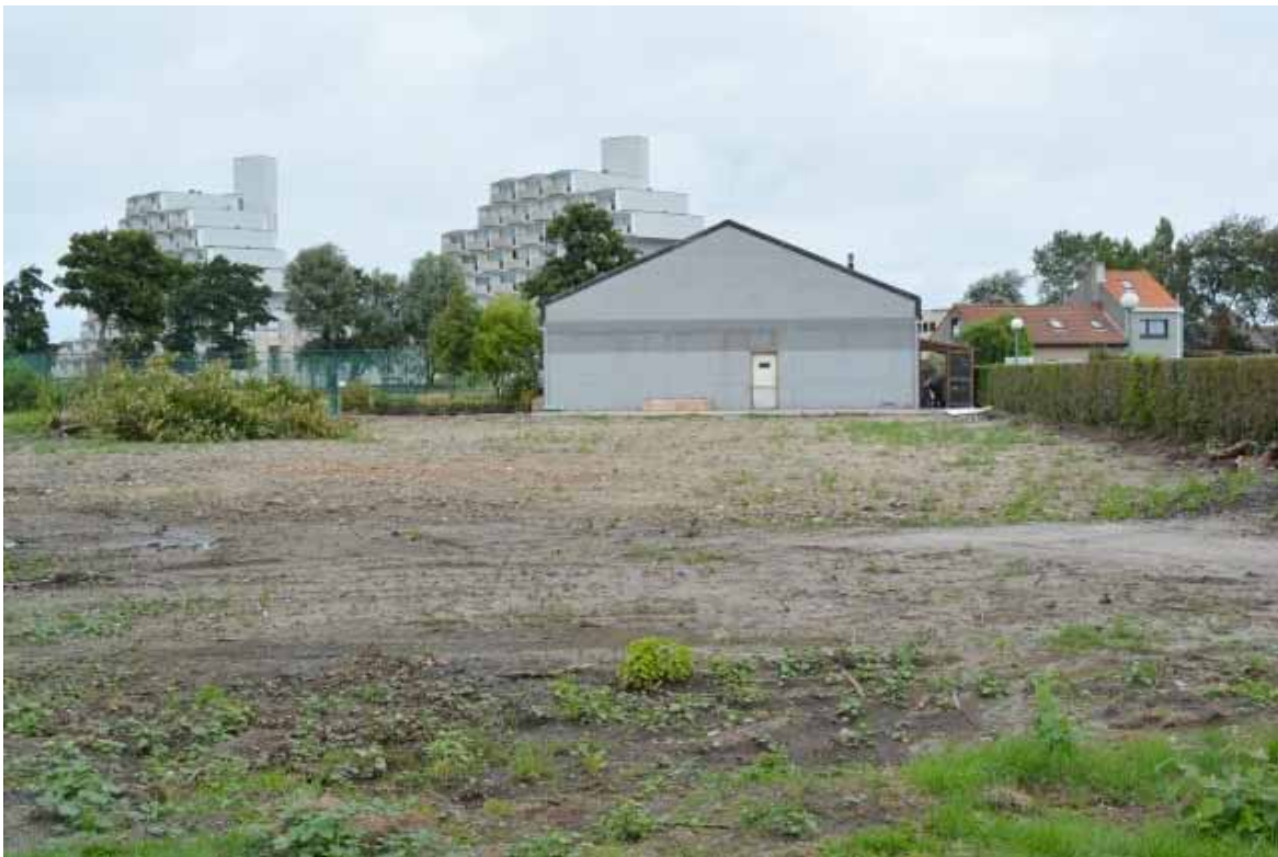
Na de afbraak van het Zwembad en de Ontspanningszaal / Après la démolition de la piscine et du hall de sports.
