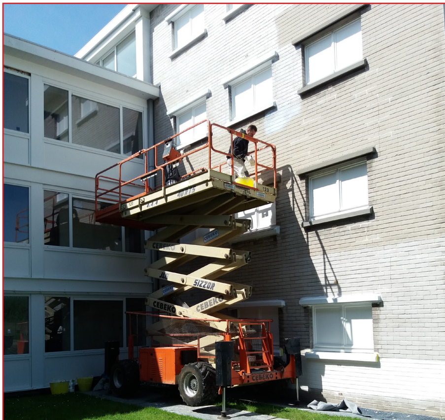
Nico en zijn medewerker, op de hoogtewerker, om de laatste muur van de bergingen op te frissen. /
