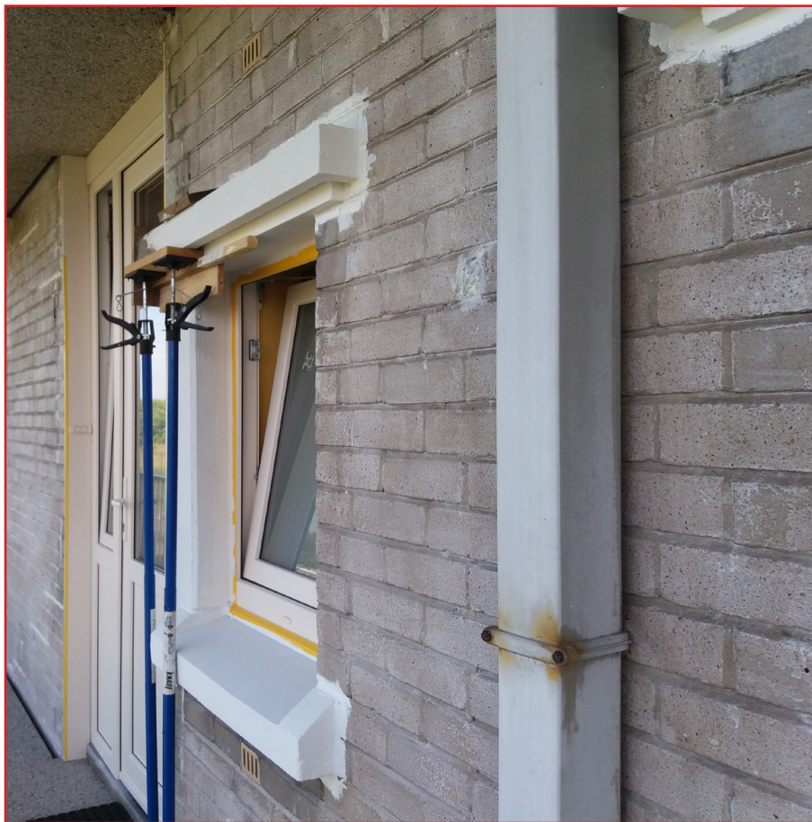
Een bijgewerkte reigel, tijdelijk ondersteund / Réparation d'un linteau provisoirement étançonné.
